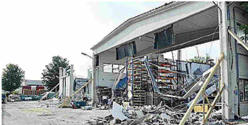
Sciagura Il capannone di un'azienda emiliana colpita dal sisma del 2012
